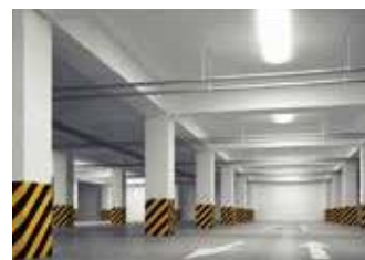
Interior de edificaciones
